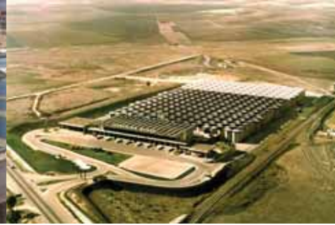
6. Design and construction of Bodega ( Las Copas) .Jerez de la Frontera
