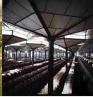
7. Design and construction of Bodega ( Las Copas) .Jerez de la Frontera
