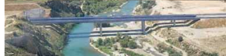
Viaduct of Sorbe EL Rio Cinca
